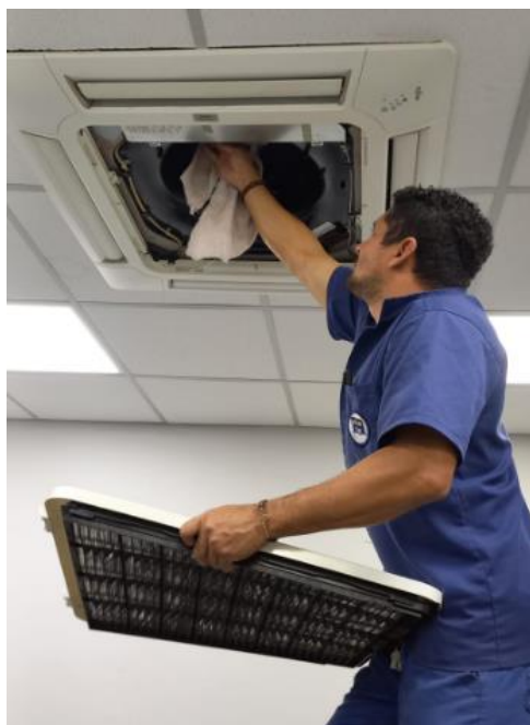
Manutenção preventiva nos equipamentos de ar Condicionado do DAS no CA.
