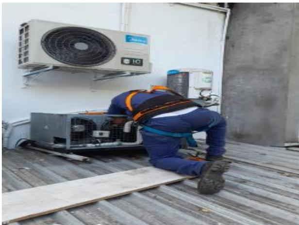
Troca de motor ventilador na unidade condensadora da câmara frigorífica no restaurante de funcionários
