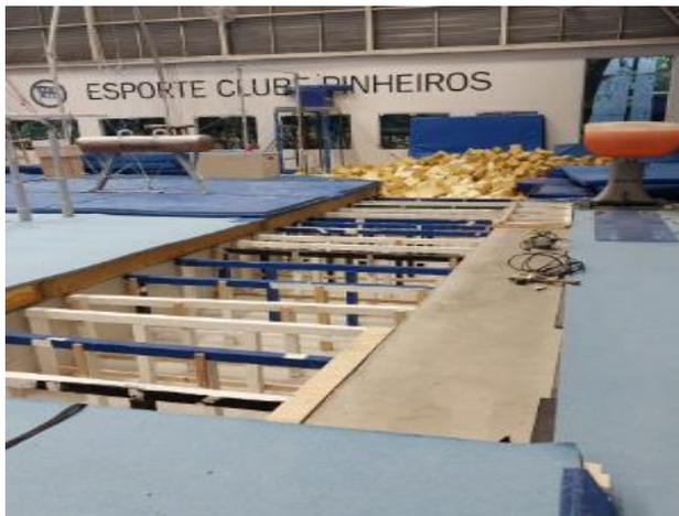
Confecção e instalação de tablado e retirada de armários com cupins do ginásio de ginástica artística
