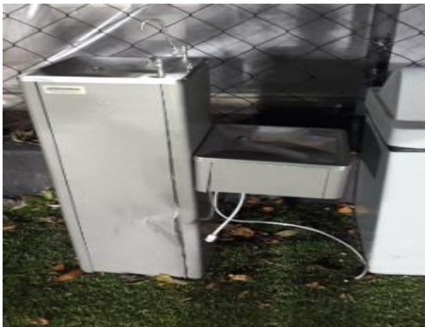
Substituída a torneira jato e o niple da mangueira do bebedouro 02 no campo A
