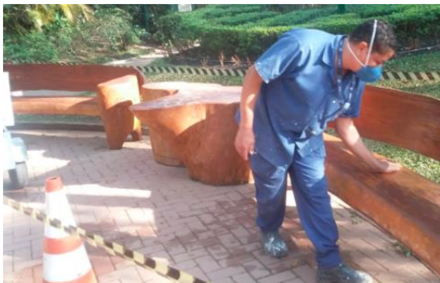
Aplicação da 2ª Demão de Osmocolor nos bancos do relógio de Flôres,
