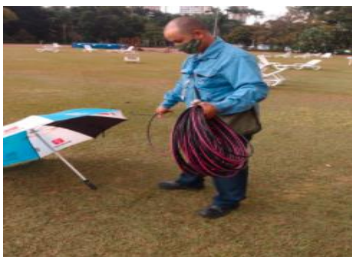
Retirada de cabos na pista de atletismo
