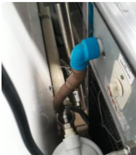
Realizada a correção na tubulação do dreno no bebedouro localizado na Cozinha central. (C, A)
