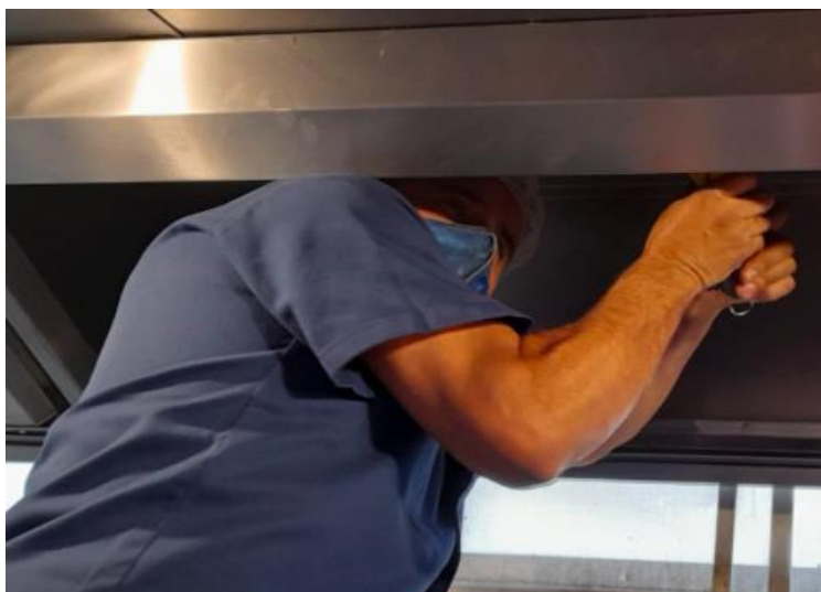
Manutenção corretiva - Realizado reparo no suporte dos filtros da coifa na cozinha central na Central de Distribuição no CA
