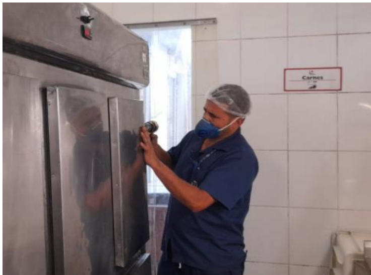
Manutenção corretiva - Realizado reparo nas portas de uma geladeira vertical no restaurante de funcionários
