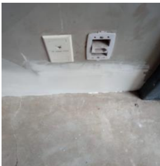
Fechamento de buraco na parede da lanchonete Alameda ok
