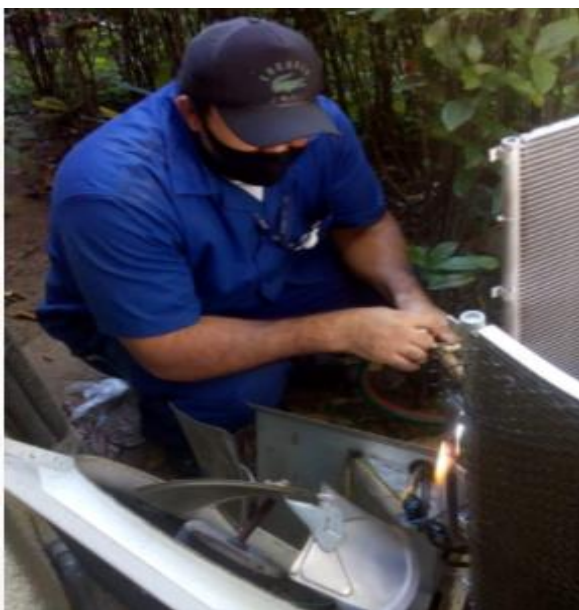
Manutenção corretiva (substituição da serpentina da unidade condensadora) de um equipamento de ar condicionado do ginásio do Esgrima
