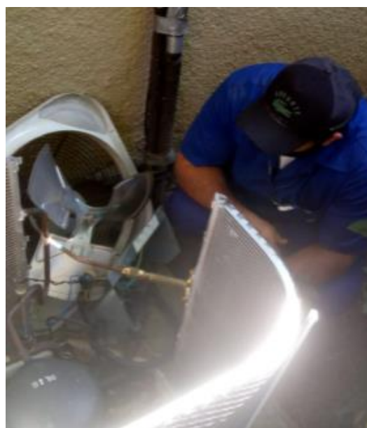
Manutenção corretiva (substituição da serpentina da unidade condensadora) de um equipamento de ar condicionado do ginásio do Esgrima
