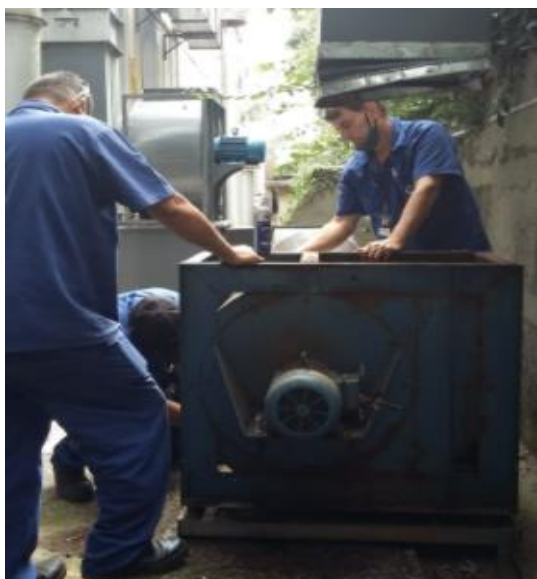
Iniciado a manutenção (troca do exaustor) do sistema de lavagem da coifa do Steak House na Lanchonete da Piscina Externa.
